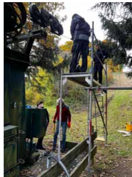
Bügel werden montiert
