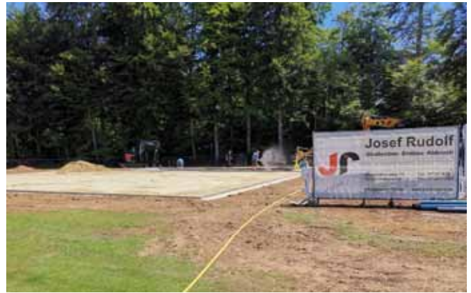
Der Sand ist fast schon komplett eingebracht
