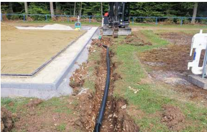
Lehrrohre für Strom sind nun verlegt
