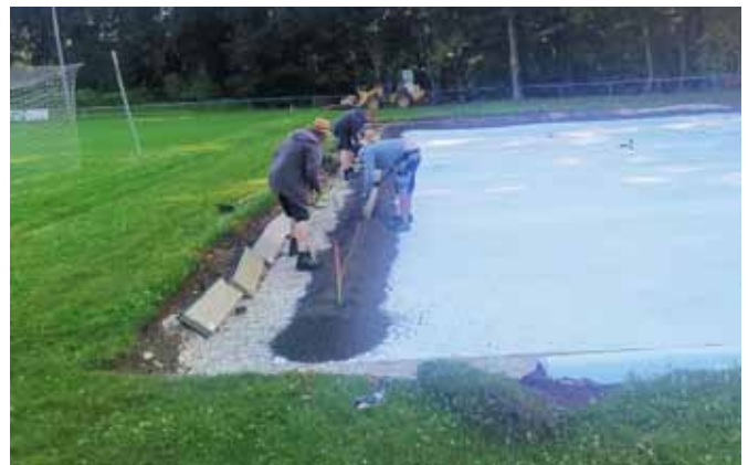
Vorbereitungsarbeiten für die Randsteine
