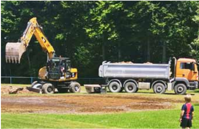
Der Aushub wird abtransportiert
