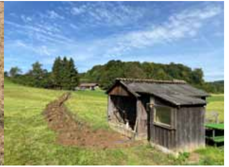
Kinderlift - Das neue Kabel ist verlegt
