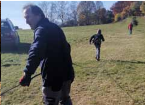
Kohltal - Liftseil wird ausgelegt
