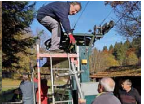
Bald können die Bügel montiert werden
